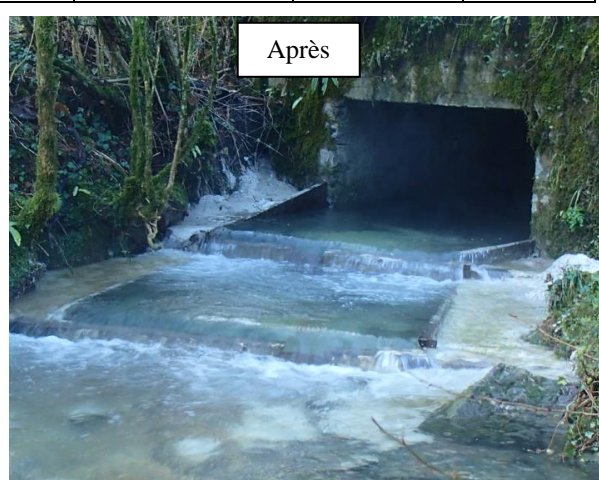
Réalisation de prébarrage sur le Mila. AAPPMA la Batbielhe
