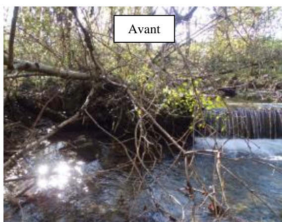
Entretien d'un seuil sur le Bayle. Une brèche existante permet de rétablir la continuité. Ce barrage, sans usage et illégal, devra être enlevé afin d'éviter la formation de nouveaux embâcles. AAPPMA le Pesquit.
