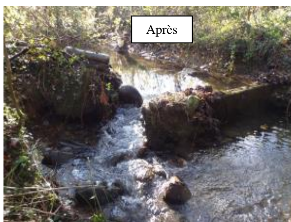
Entretien d'un seuil sur le Bayle. Une brèche existante permet de rétablir la continuité. Ce barrage, sans usage et illégal, devra être enlevé afin d'éviter la formation de nouveaux embâcles. AAPPMA le Pesquit.
