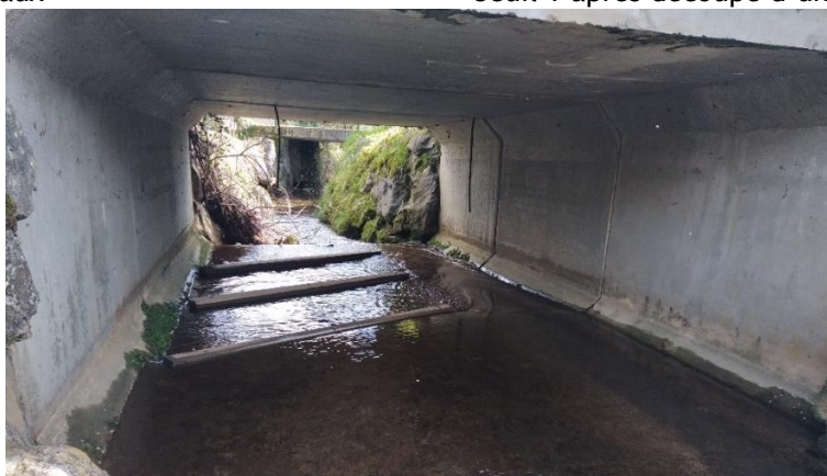
Pose de barrettes bois venant rehausser la ligne d'eau de 10 cm
