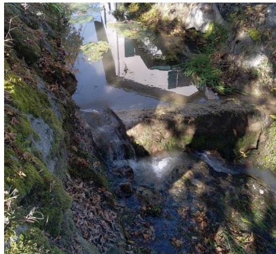
Seuil 1 après découpe d'une brèche
