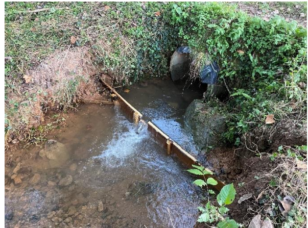
Réalisation du premier pré-barrage
