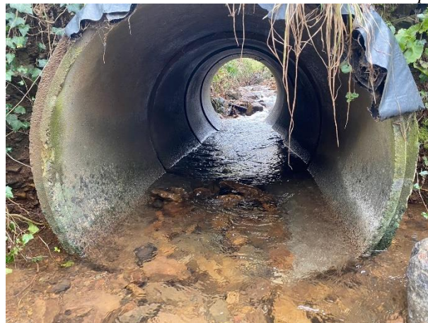
Ligne d'eau réhaussée dans la buse et chute supprimée
