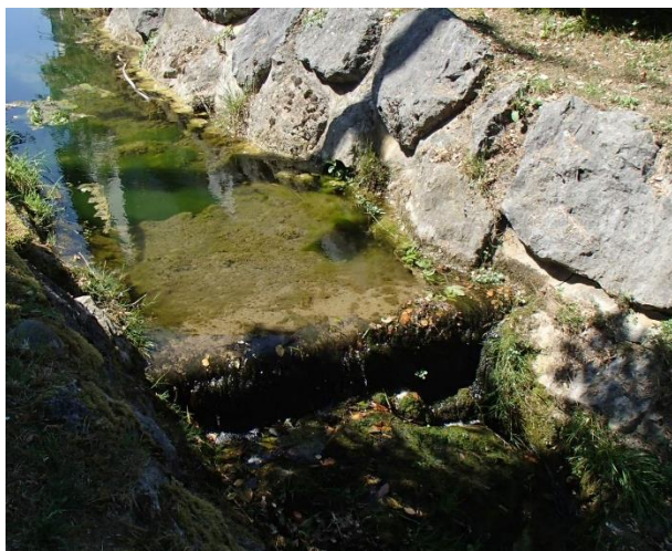
Seuil 1 avant travaux
