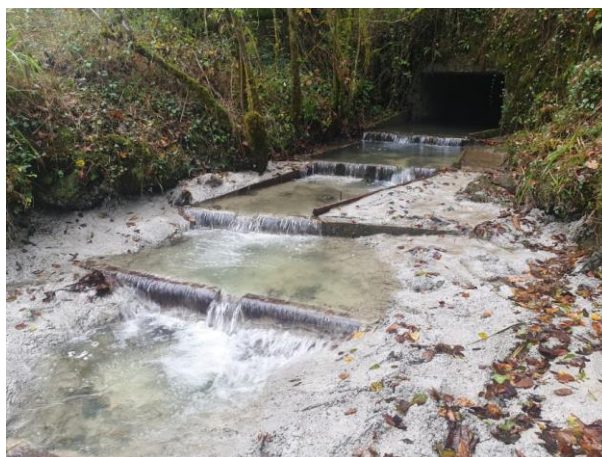
Le site après travaux
