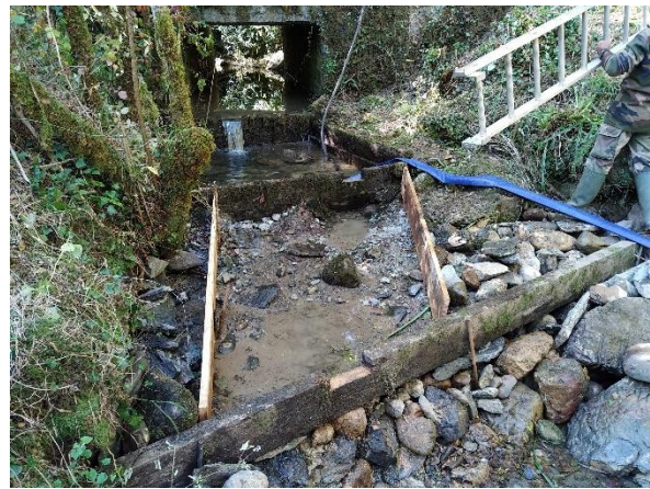
Préparation des coffrages
