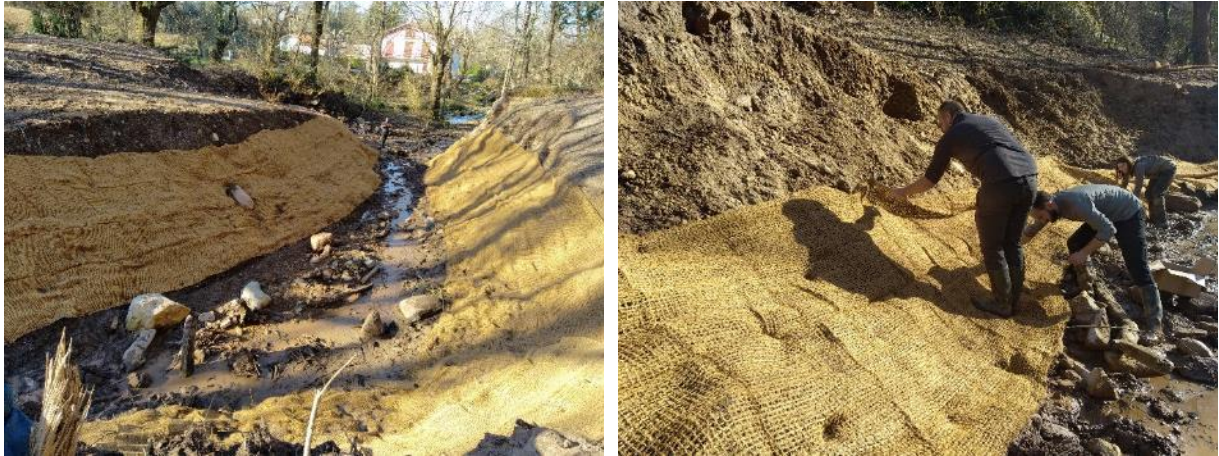
Chantier de végétalisation
