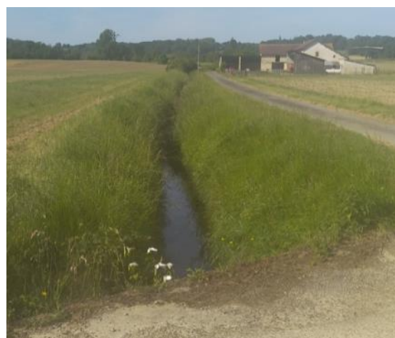
Ruisseau de Poursuigues-Boucoue, transformé en fossé...
