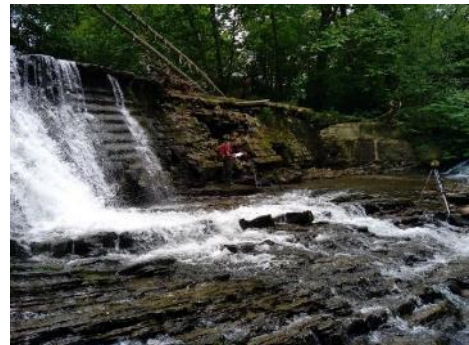
Le seuil de dérivation de l'ancienne pisciculture Darguy : 5m de hauteur de chute
