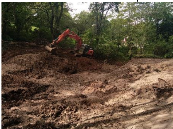
Terrassement des sédiments
