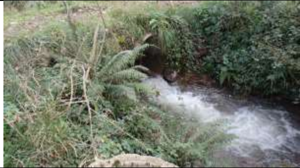
Buse n°1 avant travaux
