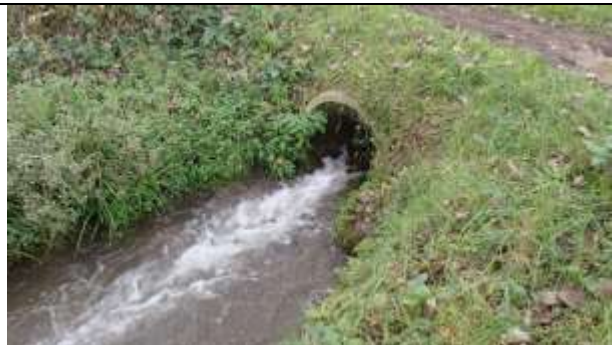
Buse n°3 avant travaux
