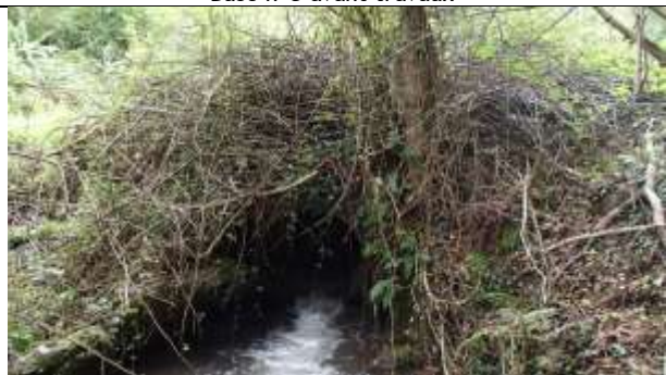
Buse n°4 avant travaux
