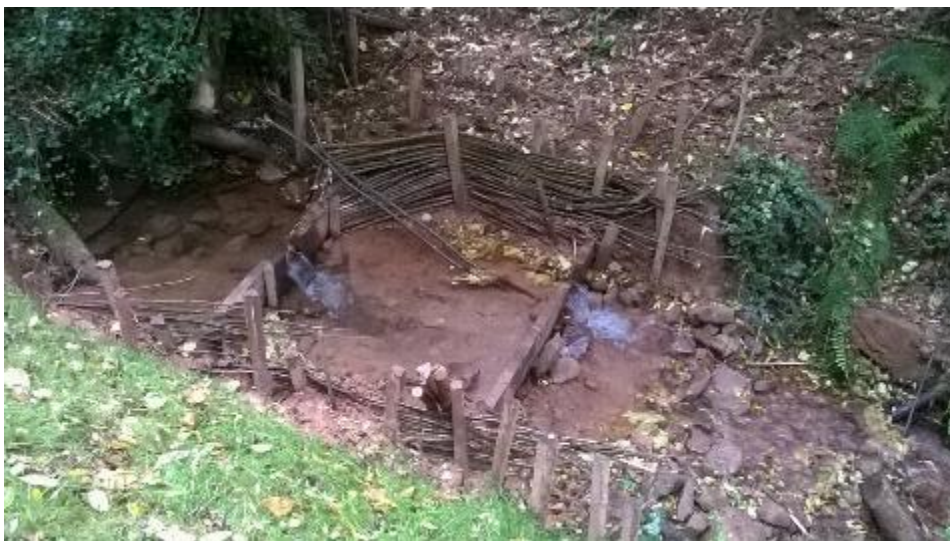
Aménagement du Fagaxuria, à l'été estival de 2015
