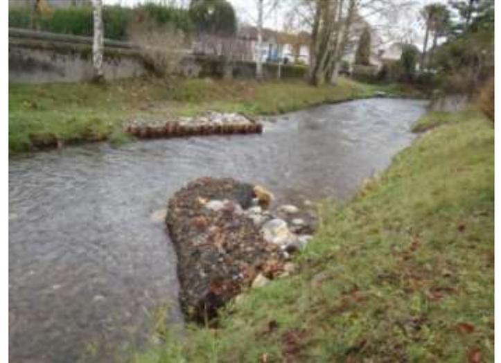
**Gabion placé en alternance avec épi**
